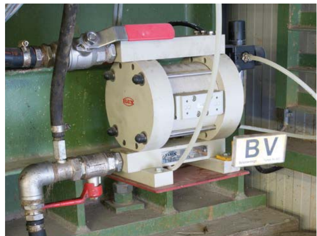
RFM – Закачивание добавок к бетонной смеси из Еврокуба в башенный смеситель
